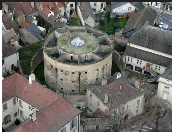
Prison d'Autun, 1855-1856, architecte : André Berthier, © Fondation du Patrimoine
